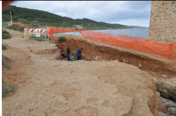
Foto 6. Torre di Abbacurrente: scarico idraulico in trincea
