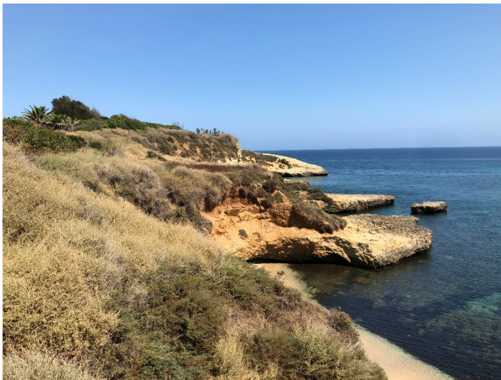
Vista della sommità del versante da consolidare con un muro di sostegno.
