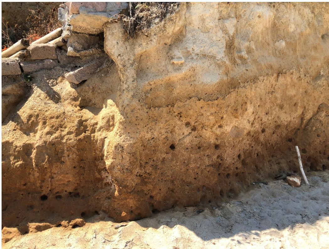
Particolare della parte inferiore della falesia dove è presente la scala di accesso alla spiaggia.
