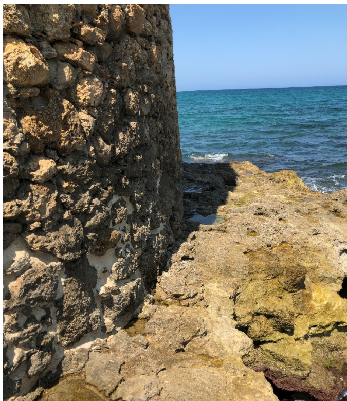
Vista della fondazione della Torre sul lato rivolto a Est.
