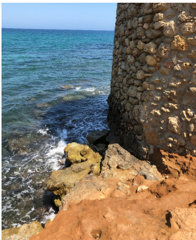
Vista della fondazione della Torre sul lato rivolto a Ovest.
