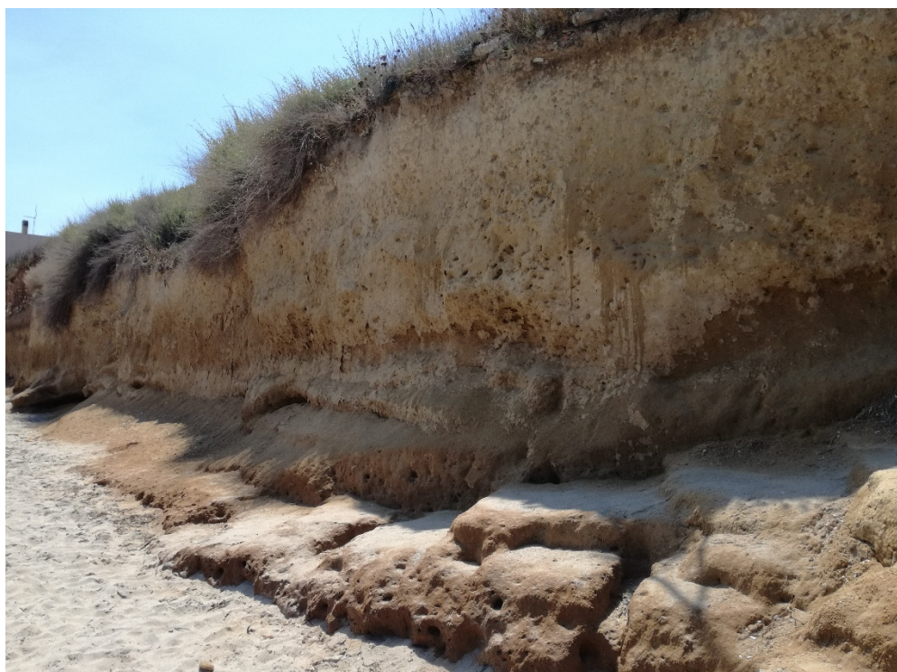
Vista della zona posta alla sinistra della scala di accesso alla spiaggia.
