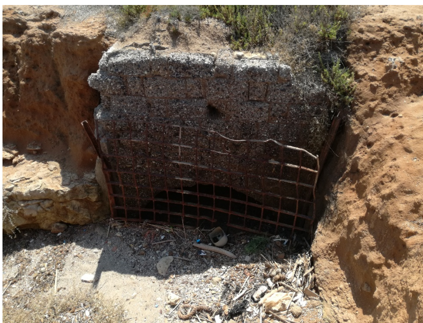
Vista dello scarico idrico situato a poca distanza dalla Torre.
