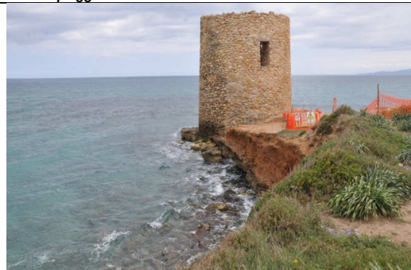
Foto 5. Torre di Abbacurrente: effetti dell'erosione costiera sul basamento roccioso
