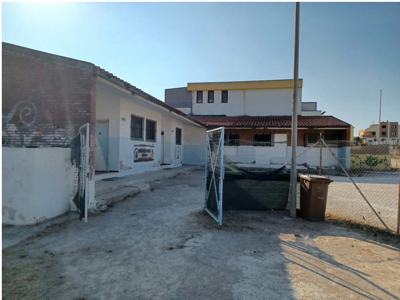
Spogliatoi a servizio del Campo 2. Vista da nord
