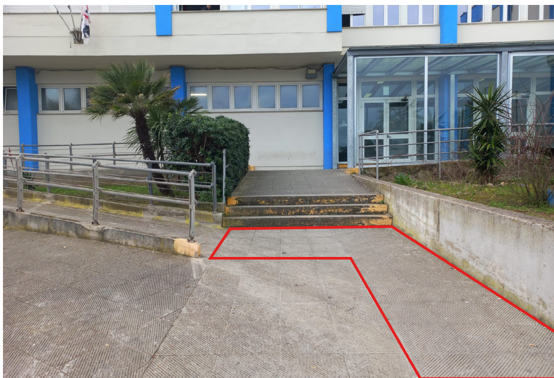
Indicazione della pavimentazione oggetto intervento per ripristino delle pendenze trasversali.
