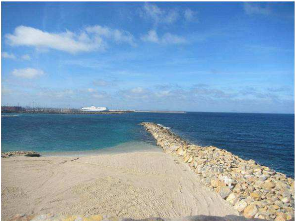
Figura 40. Il pennello artificiale e il deposito sabbioso derivante dal ripascimento con inerti da cava
