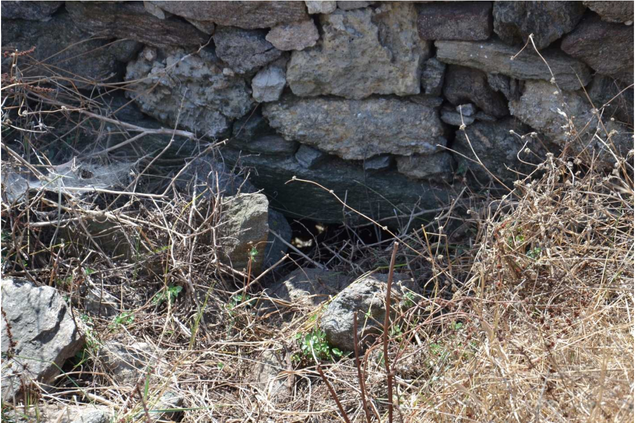
Dettaglio dell'imboccatura sotto il muro di bordo della strada
