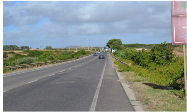
La strada provinciale all'ingresso del rilevato realizzato per superare l'avallamento in cui scorre l'affluente oggetto della presente documentazione
