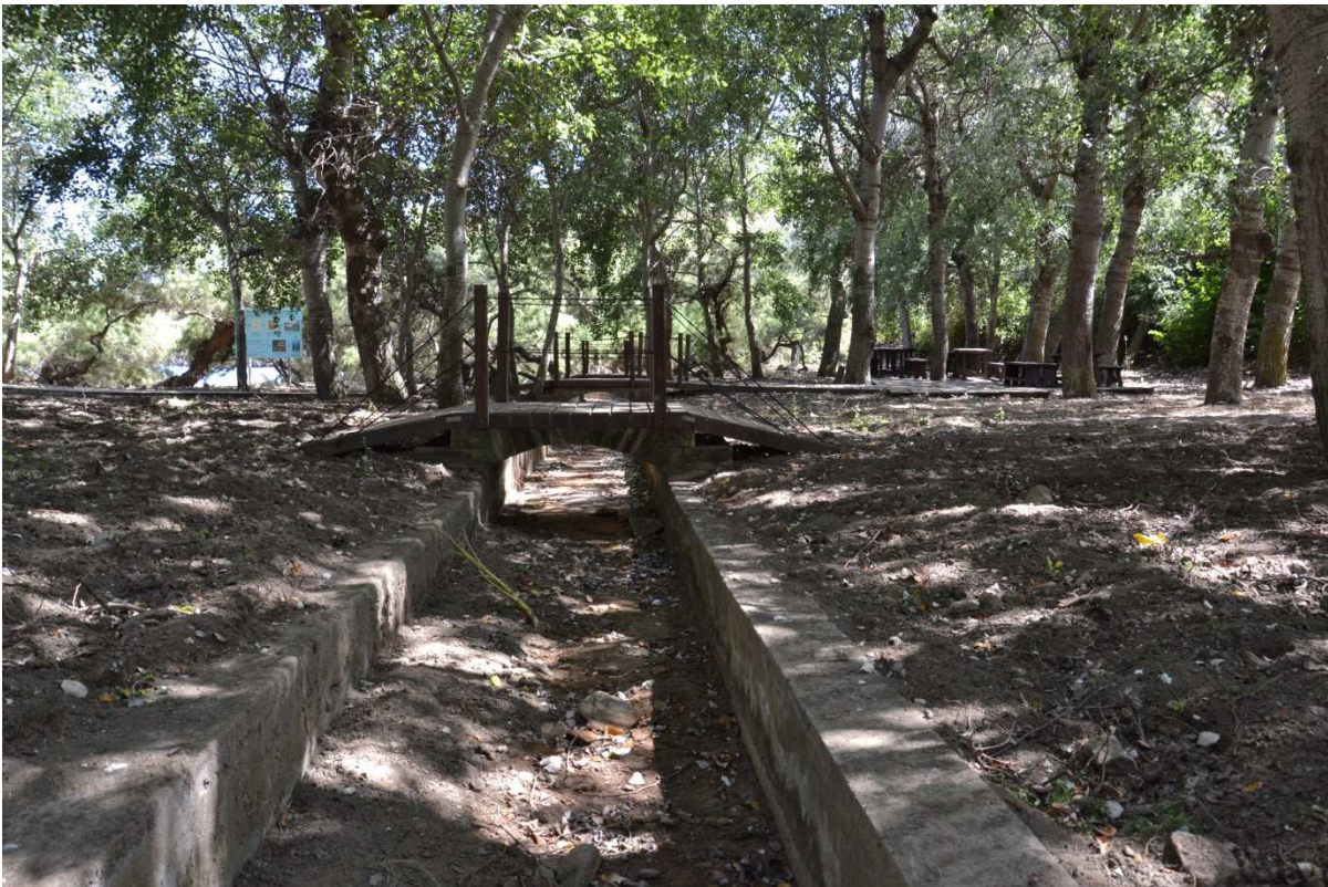
Il tratto dell'asta fluviale tra lo sbocco a mare e l'intersezione con lastrada principale. Il tratto è stato sistemato come parco per la sosta dei turisti. Sono presenti dei ponticelli pedonali in legno che attraversano il canale sistemato che addice le portate ordinarie al mare. Il canale non è in grado di smaltire le piene oggetto del presente studio.
