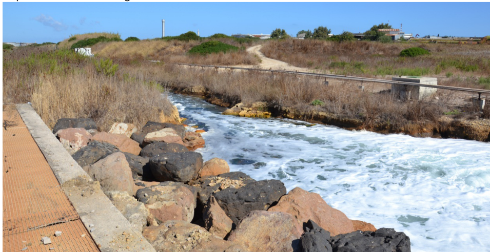
Il tratto in cui fluiscono le acque di raffreddamento. La portata è di circa 3 mc/sec
