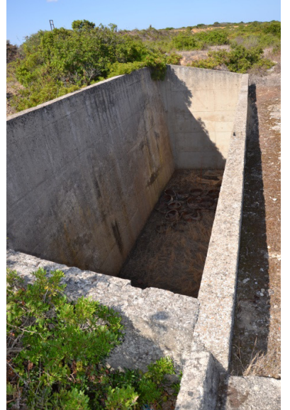
Una delle strutture realizzate nel compluvio naturale per il passaggio delle condotte verso serbatoi mai costruiti. A sinistra il tratto a valle e a destra il tratto a monte di una strada interna.
