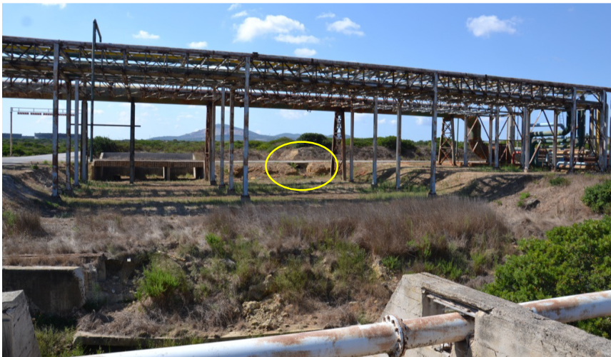
L'ultima parte del tratto tra le sezioni 30 e 40 (con orientamento sud-nord) prima dell'immissione nel canale principale (foto a destra). Col cerchietto è evidenziata la sezione naturale dove dovrebbe scorrere l'asta naturale. L'immissione nel canale che scorre parallelo alla costa avviene in un tratto dove è stato abbattuto il muro di contenimento del canale (foto a sinistra) ed in basso nella foto a sinistra.
