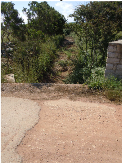
Il ponticello in corrispondenza dell'intersezione 3, vista del tratto a monte
