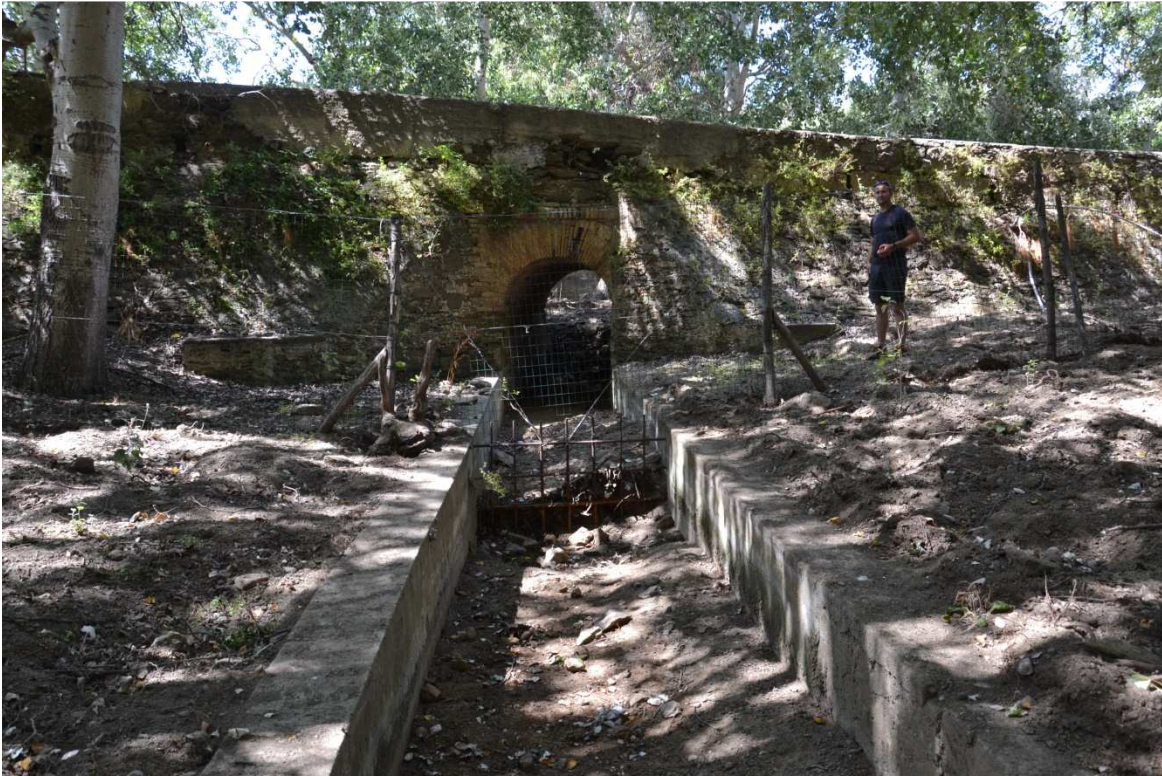
Il ponticello sulla strada principale, realizzato in pietra. A monte è in parte ostruito dalla sistemazione successiva che ha sollevato la quota di campagna (vedo foto sottostante)
