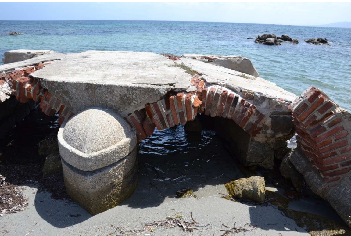
Particolare dello sperone, in granito, che caratterizzava un vecchio ponticello posto su una strada litoranea non più esistente, ora praticamente in mare a disostrazione dell'innalzamento del livello marino (o dell'abbassamento di questo tratto della Sardegna)
