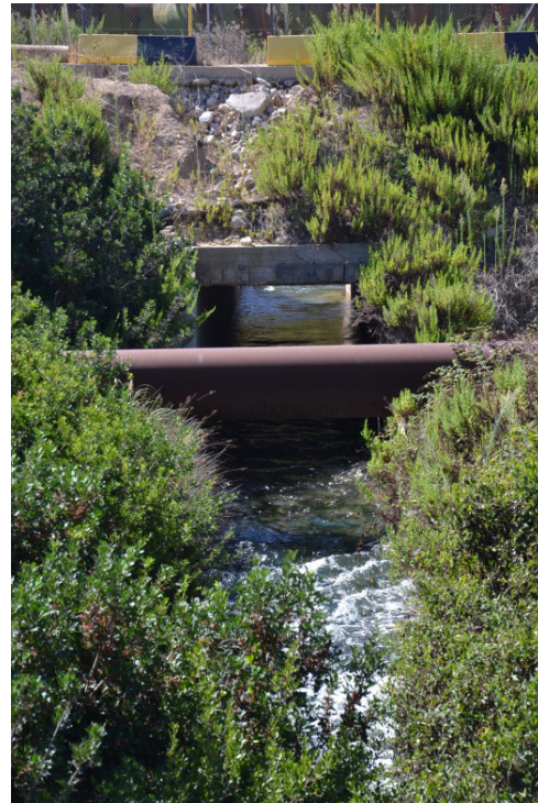
Il secondo ponte visto da valle, anch'esso con sezioni idonee al passaggio delle piene in studio. Può essere messo in crisi dalla presenza del ponte, da cui è effettuata la foto, ubicato immediatamente a valle.
