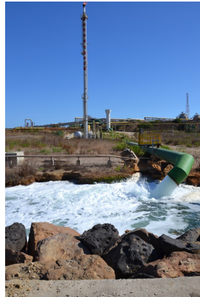
Lo scarico delle acque marine di raffreddamento degli impianti
