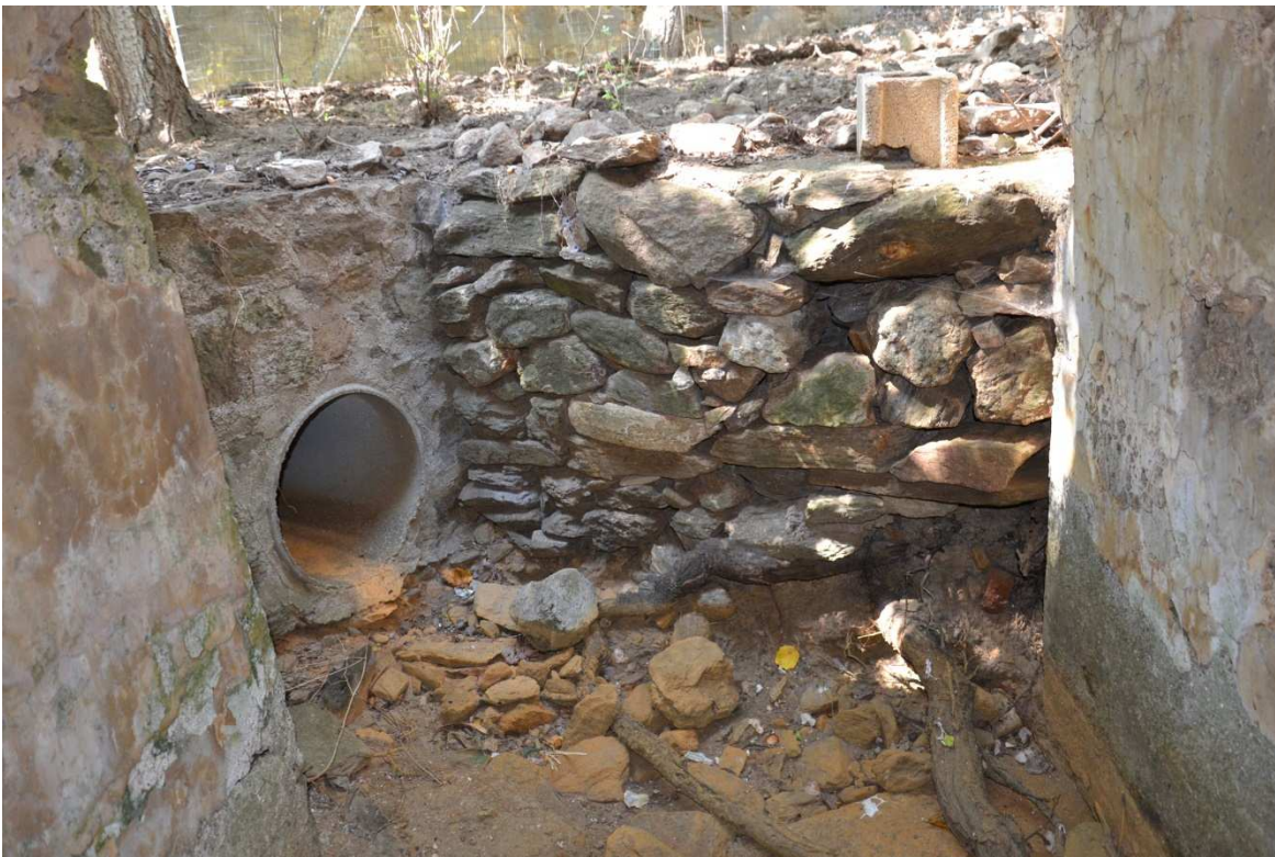
Il ponticello sulla strada principale, realizzato in pietra. A monte è in parte ostruito dalla sistemazione successiva che ha sollevato la quota di campagna (vedo foto sottostante)
