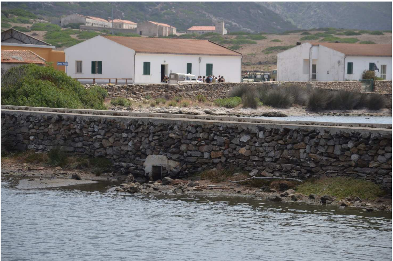
Lo sbocco a mare dello stagno, a monte della strada principale. La strada funziona come una traversa di regolazione e controllo degli scambi di acqua dolce-salmastra
