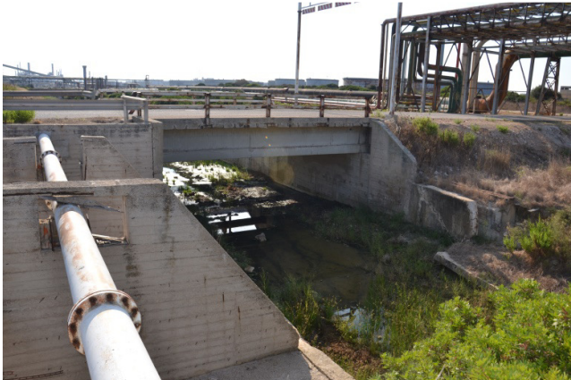
Foto del ponte (a sinistra da monte e a destra da valle) posto nel canale principale immediatamente a valle dell'immissione dell'asta principale e che non risulta adeguato a smaltire neanche le portate associate a periodi di ritorno di 50 anni.
