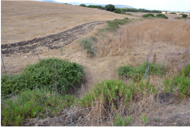
Il tratto a monte della strada provinciale per Stintino. La recinzione in rete evidenzia l'imboccatura del sottostante tombino.
