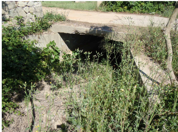
Il ponticello in corrispondenza dell'intersezione 3 visto da monte
