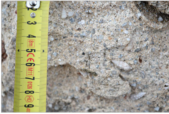
fig. 12 – Malta in cui è evidente l'impiego di conchiglie marine tra gli inerti (foto A. Urgu).
