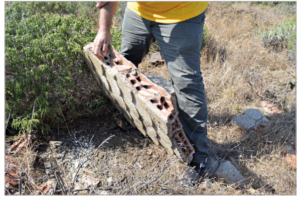
fig. 13 – Lacerto della copertura in laterocemento della cappella di Stretti (foto A. Urgu).
